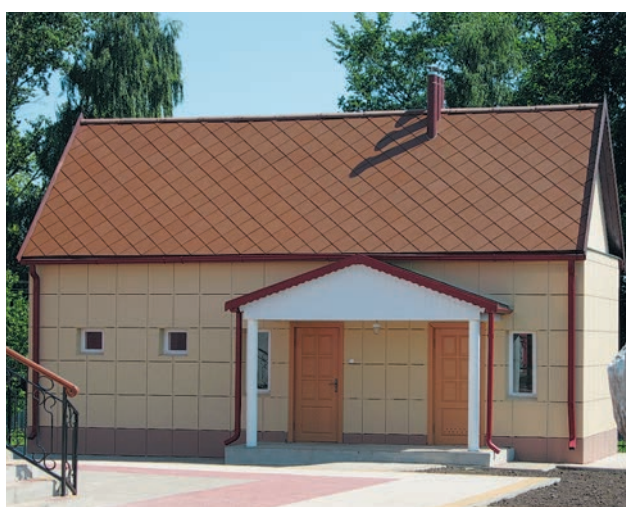
Рисунок 5.2. Примеры применения мелкоразмерных хризотилцементных плиток
