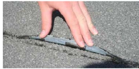
Рисунок 12.1. Несклеенные полотнища наплавляемого рулонного материала в нахлестах по кромкам продольной (а), торцевой (б)
