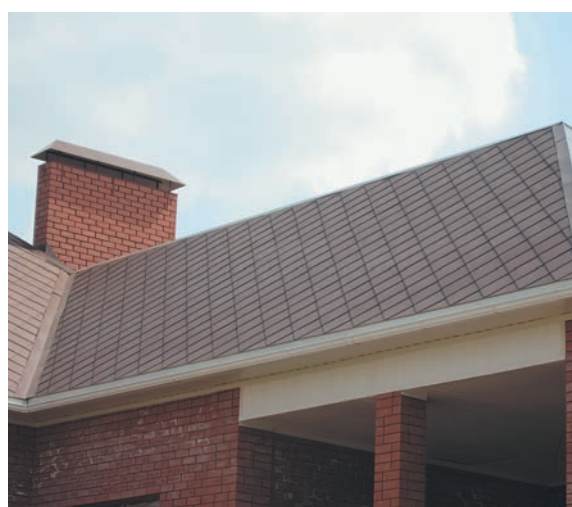
Рисунок 5.2. Примеры применения мелкоразмерных хризотилцементных плиток
