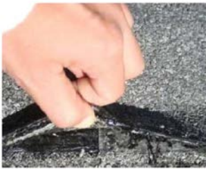
Рисунок 12.1. Несклеенные полотнища наплавляемого рулонного материала в нахлестах по кромкам продольной (а), торцевой (б)
